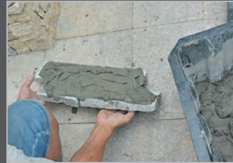
Passenden Kleber an Verblender auftragen
