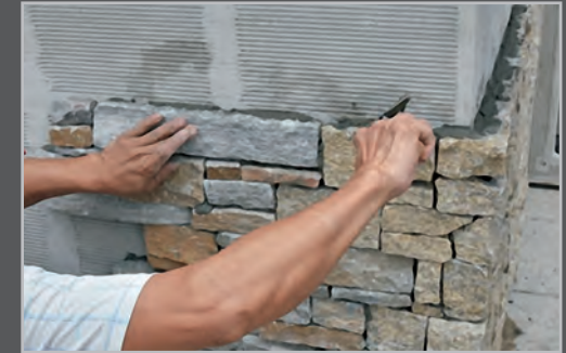
Verblender am Küchenmodul anbringen und ausrichten
