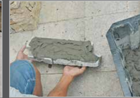
Passenden Kleber an Verblender auftragen
