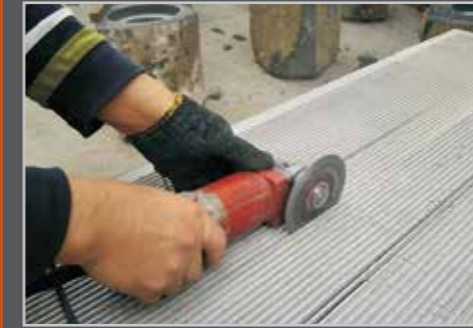
Einfacher Zuschnitt mit Winkelschleifer oder Handsäge
