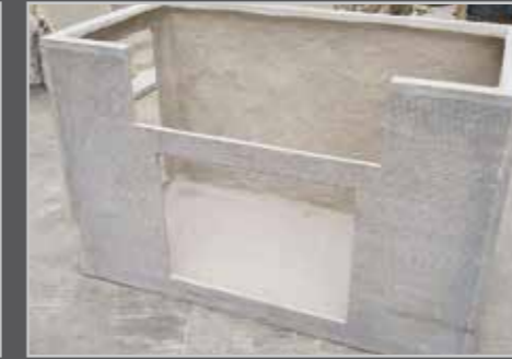
Ausschnitt für Einbaugrill und Türen herstellen
