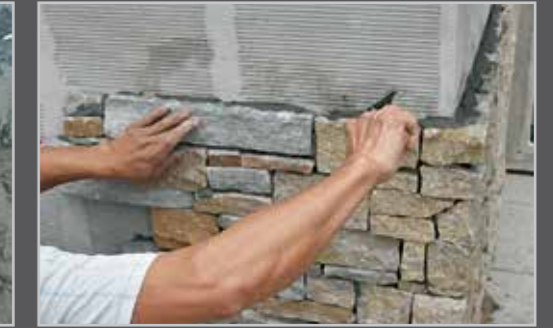
Verblender am Küchenmodul anbringen und ausrichten
